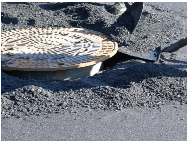
Повдигнете капака и поставете асфалт под капака
