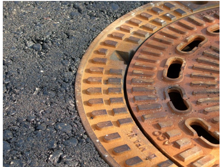
Минете през капака с вибриращ валяк за да направи равна повърхност с пътната настилка
