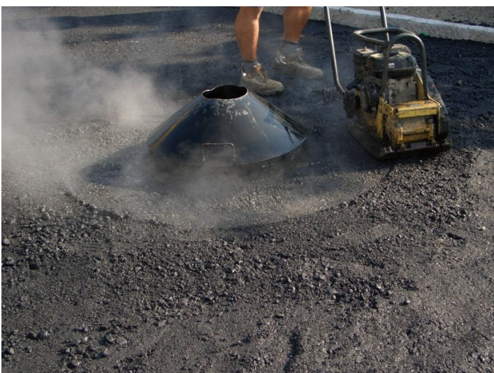
Поставете модела за монтаж върху пръстена на адаптера
