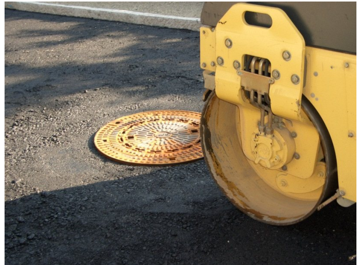
Минете през капака с вибриращ валяк за да направи равна повърхност с пътната настилка
