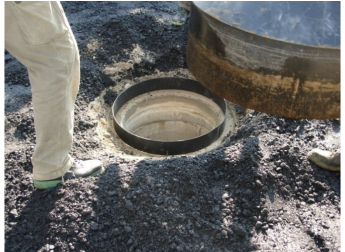
Инсталирайте адаптерния пръстен
